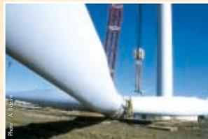
Après le montage du rotor au sol, ce dernier est hissé en haut de mât pour être fixé sur la nacelle.
