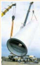
Installation du premier segment sur le socle bétonné et fixation à l'aide de plus de 140 chevilles.
